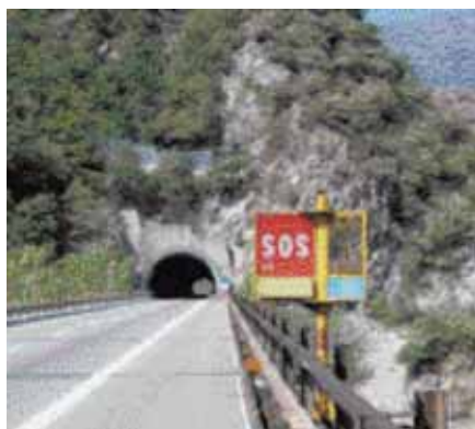
Quincinetto - Aosta Colonnine SOS a chiamata passiva (distanza media di 1.000)
